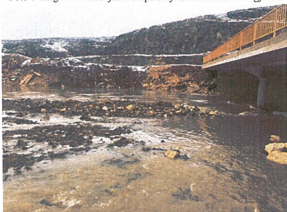
Foto 9 Demtimi i skarpateve te Lumit L.Prenku Dobroshec
