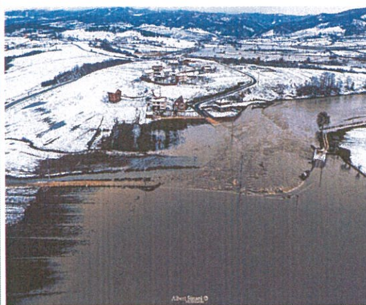
Foto 44 Dëmtimi i trupit të rrugës dhe urës në Lagjën Avdyli
