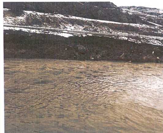
Foto 12 Denti gërryerja e pjeses se bankines L.Prenku
