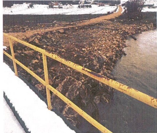
Foto 20 Demtimi i rruges dhe kanalizimit ne L.Mehani Qikatov
