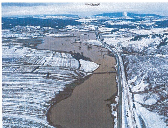
Foto 48 Vërshimet në lagjën Ademi-Dëmtimi i Urës dhe trupit të rrugës
