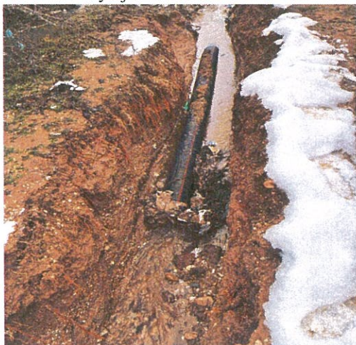
Foto 28 Demtimi i kanalizimit
