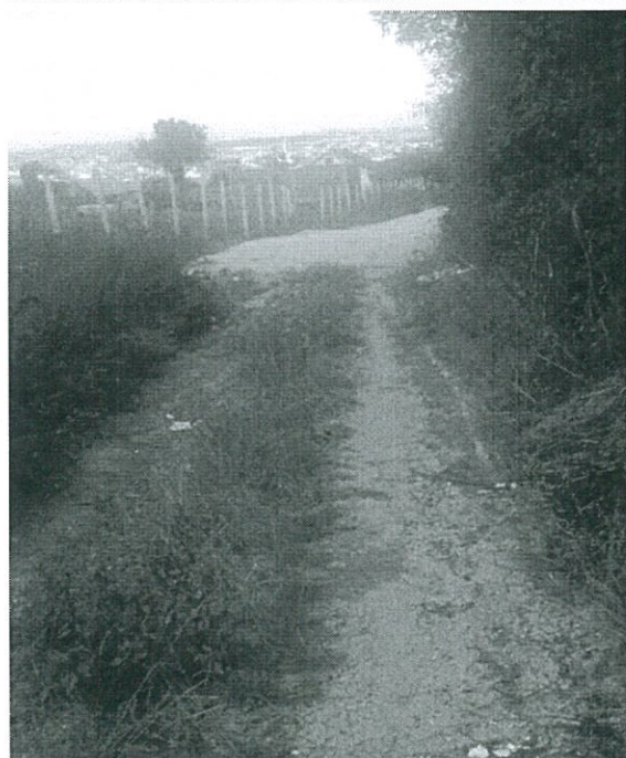
Fig.5.Nderpreja e punimeve në rrugën deri në përfundimin e saj
